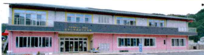
写真上から / 月ヶ瀬インター・道の駅伊豆月ヶ瀬(天城)、御幸橋架け替え工事(修善寺)、津波避難タワー(土肥) ないかず認定こども園(中伊豆)
